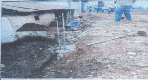
Foto 1: Muro en construcción
