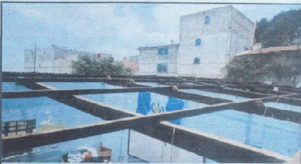
Foto 3: Muro en proceso
